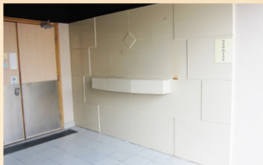
屯門醫院殮房外的石屎牆鋪砌成為磚牆，讓親友放置鮮花及死者相片等
