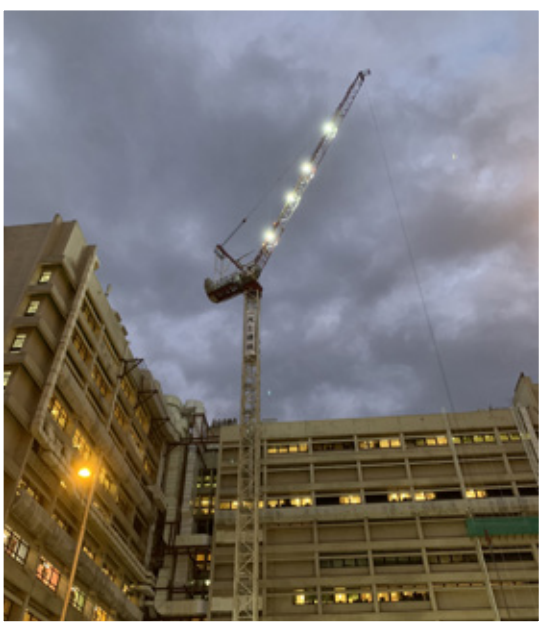
工程承辦商在起重機吊臂安裝了照明燈，確保工地夜間的安全。
