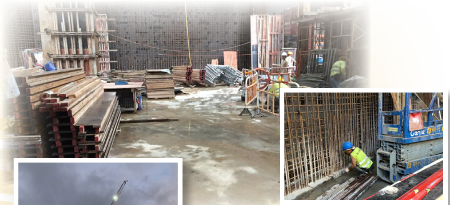
新手術室大樓的兩層地庫，工程大致完成。
