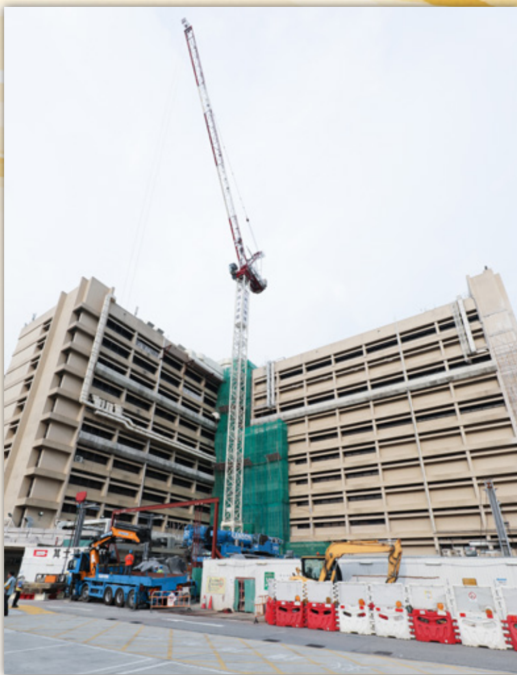
起重機已經正式豎立，意味工程踏入新階段。
