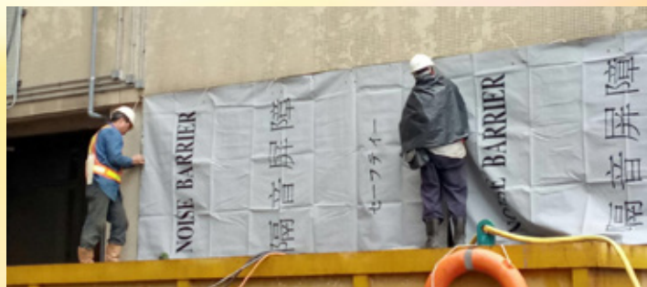
工地人員裝置隔音屏障，以消減噪音。
